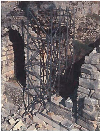
Die Stützkonstruktion am Südanalemma (2010)
