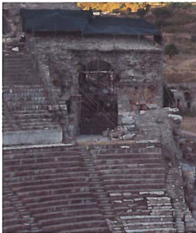
Restaurierungsarbeiten am Südanalemma
